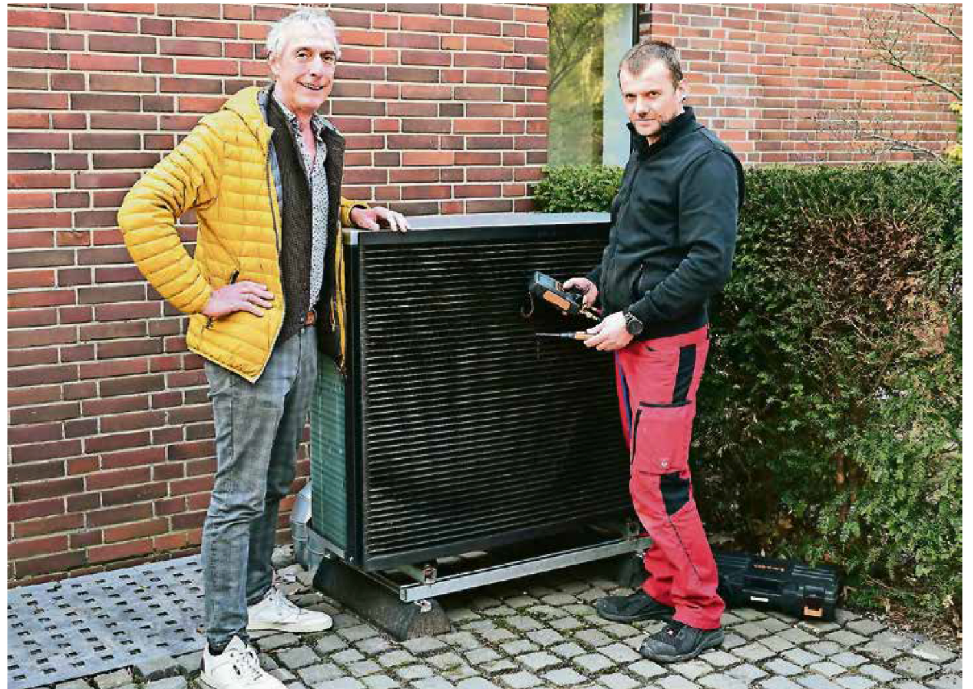
Krefelds Innungs-Obermeister Wilhelm Gobbers (l.) mit Techniker Stefan Berns an einer Luft-Wasser-Wärmepumpe. Bei der Installation müssen Abstände zu Nachbargebäuden eingehalten werden, da die Ventilatoren Geräusche verursachen.
