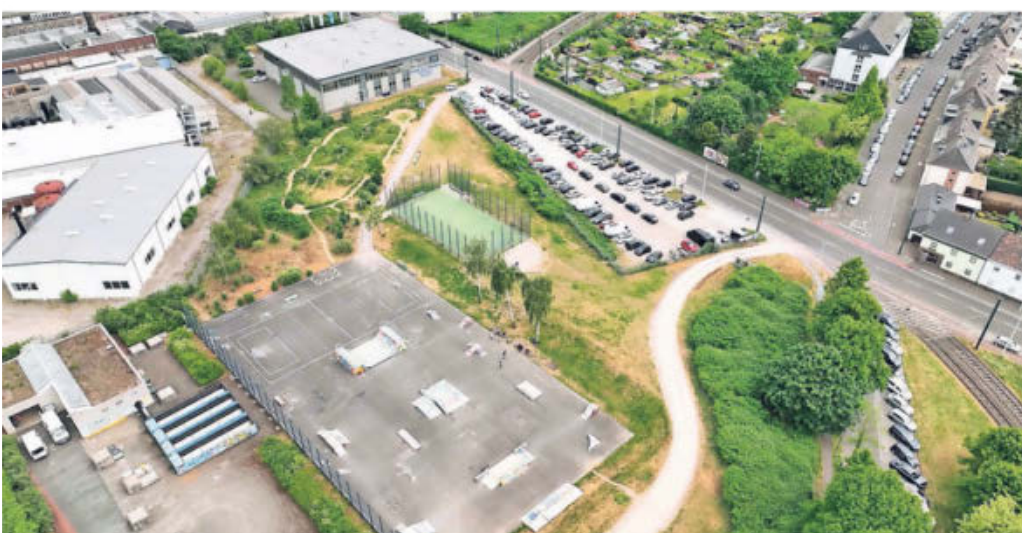
Die Lage des Wärmespeichers auf der Luft. Entstehen wird er zwischen dem Parkplatz an der Ritterstraße (oben) und den benachbarten Sportflächen.
